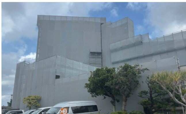
劇場棟南面（管理事務所側）
