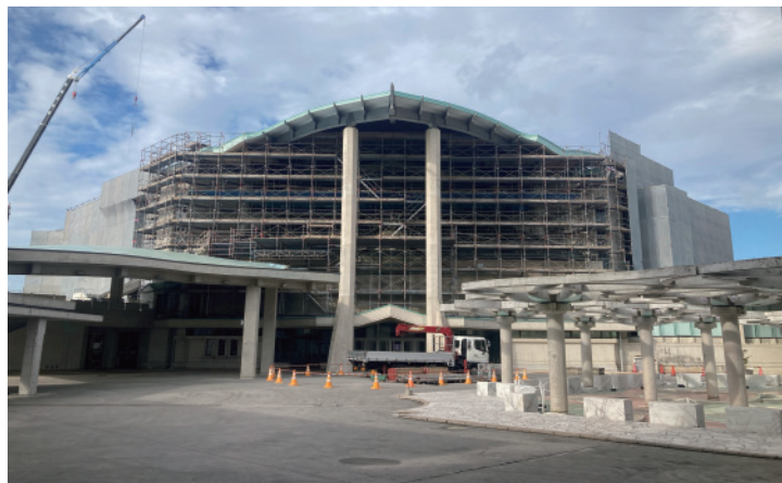
劇場棟東面（正面入口側）
